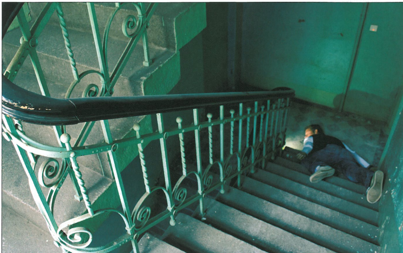
Der versicherte Weg beginnt erst nach Durchschreiten der Außenhaustür.
