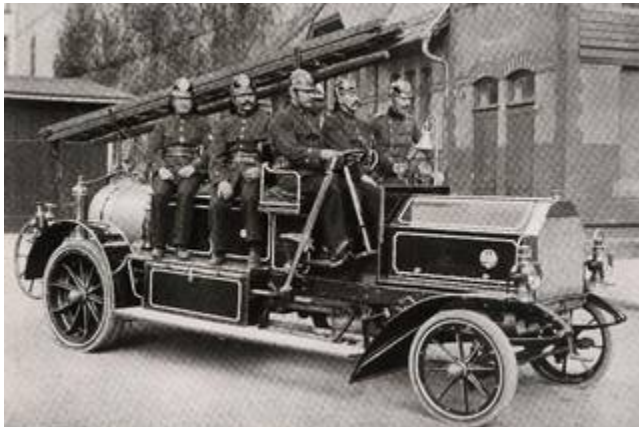
Benzingetriebene Gasspritze im Hof der Feuerwache Burgstraße
