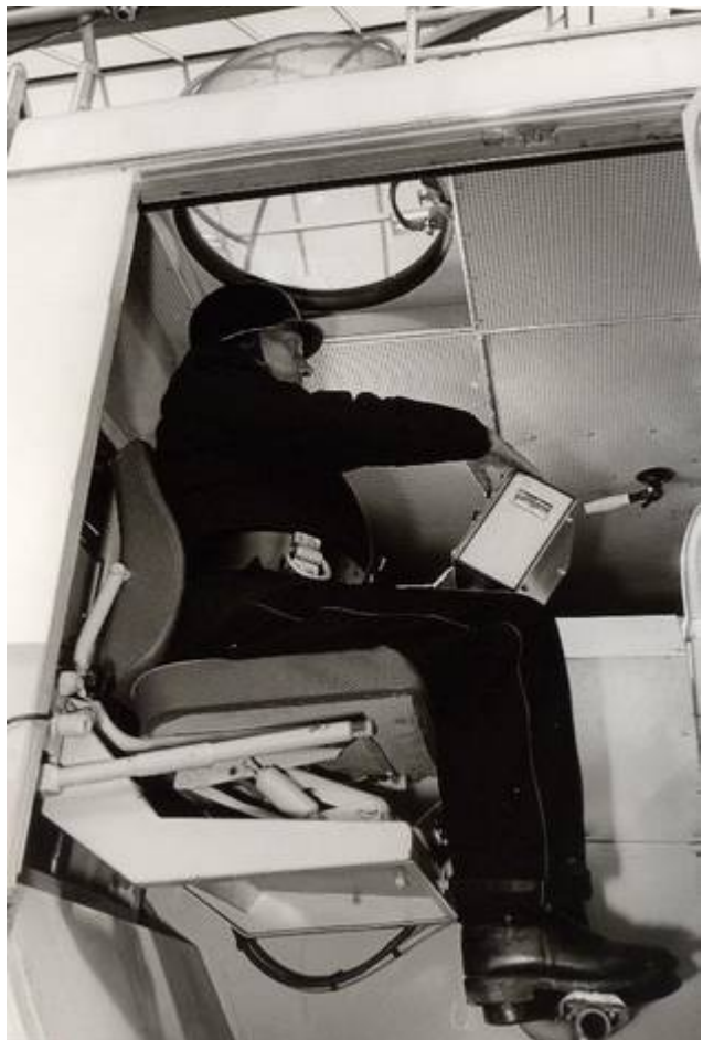
Blick auf die andere Seite der Kabine: Fernbedienung des Monitors vom Beifahrersitz
