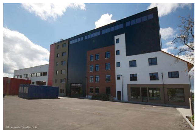
Freigelände zwischen Übungshalle und Realbrandhalle
