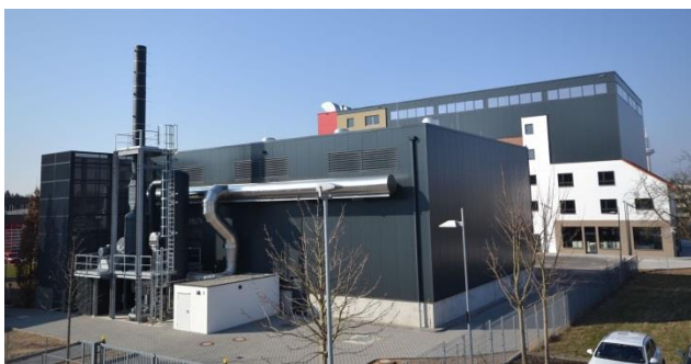
Fast fertig: vorn die Realbrandhalle mit Brandrauchreinigungsanlage, im Hintergrund die Übungshalle
