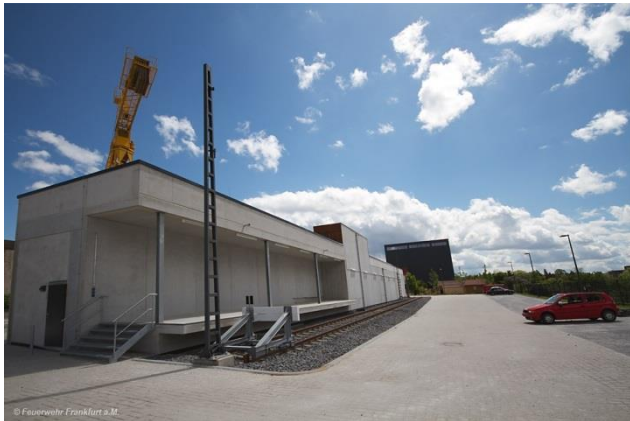
Außengleis mit Laderampe des Übungsbahnhofes
