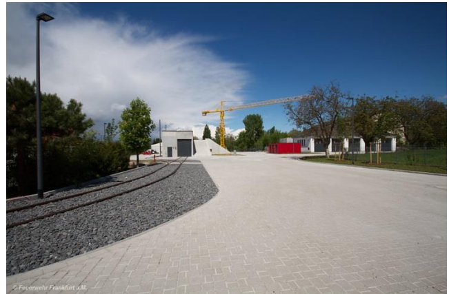
Freigelände zwischen Übungshalle und Übungsbahnhof
