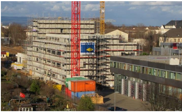
Dezember 2011: Der Rohbau wächst schnell
