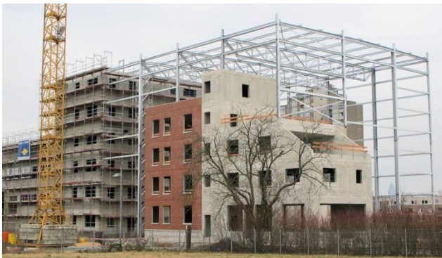
Das Grundgerüst der Übungshalle steht
