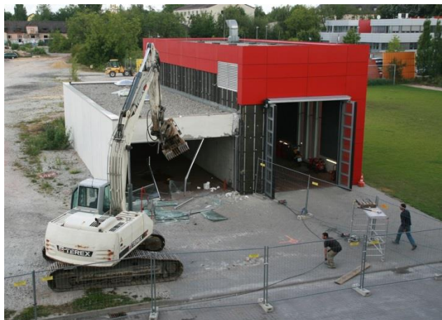
Juli 2011: Abriss Reifenlager
