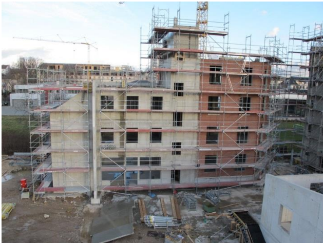
Bau der Übungshäuser „unter freiem Himmel“
