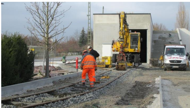
November 2012: Gleisbauarbeiten zwischen Übungshalle und Übungsbahnhof
