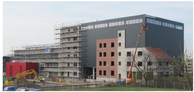
Die schützende Hülle kurz vor der Fertigstellung
