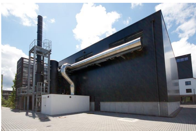
Rückwärtige Ansicht der Realbrandhalle mit Abgasreinigungsanlage
