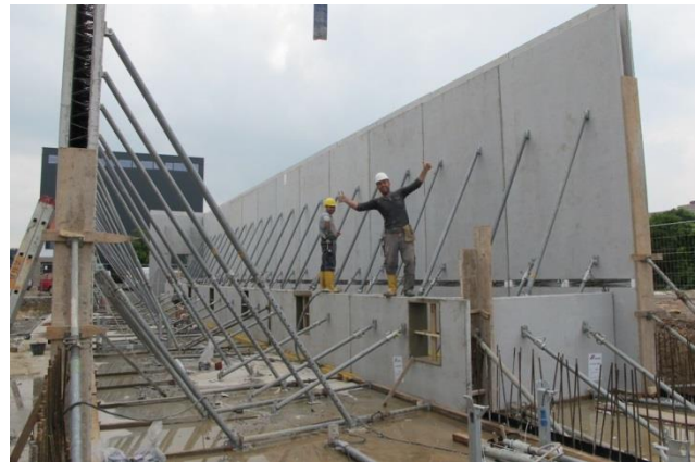
Baustelle Übungsbahnhof im Juni 2012
