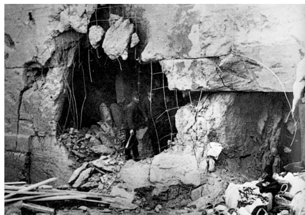
Zerstörung durch Luftmine am Bunker Mühlgasse
