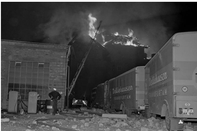
Im Hof an der Frankenallee. Die oberen Leiterteile der Drehleiter von Zug 4 sind ausgeglüht. Foto: Karl-Heinz Bohnacker, Bildrechte: ISG
