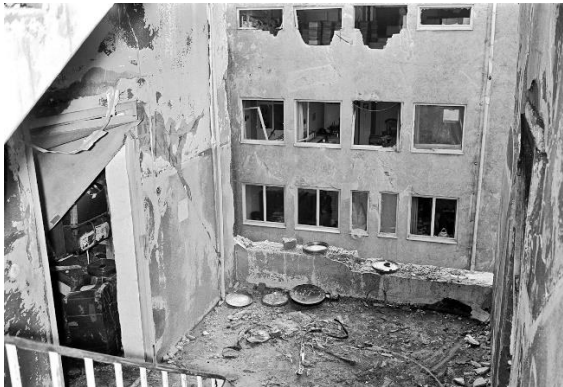
Herausgesprengte Mauer des Treppenhauses mit Blick auf das Gebäude der Firma Delliehausen.
